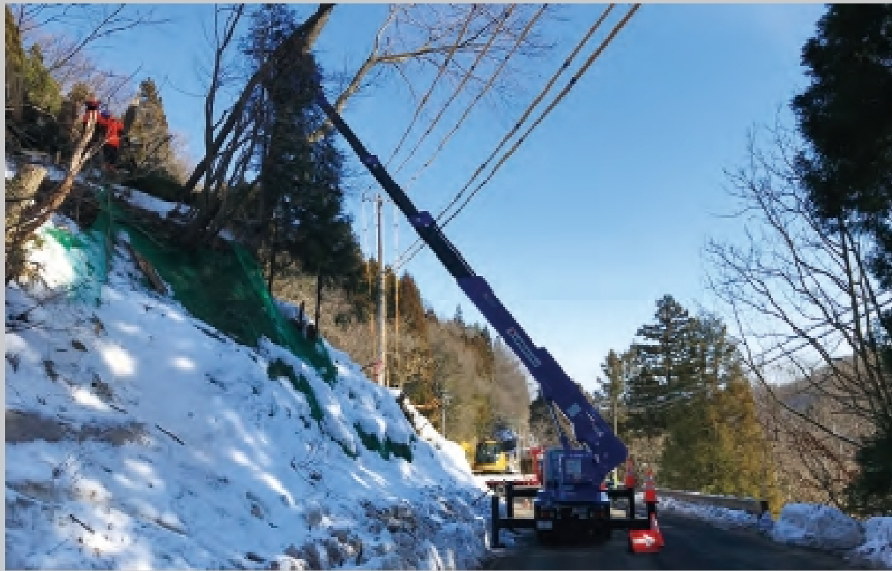
福島先達山 太陽光発電所 建設工事 伐採工
