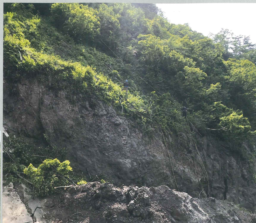
田麦俣地すべり七ツ滝ブロック 溪流保全工事 法面伐採工
